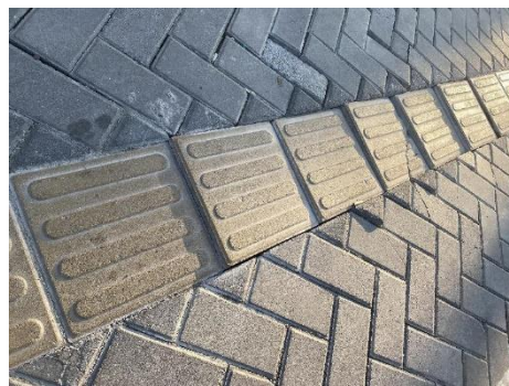
圖 6 盲道磚斷裂、不平
