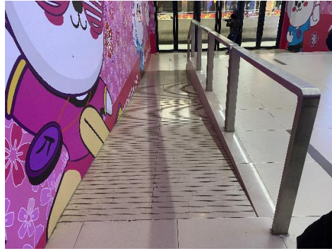
圖 35 二樓側門的無障礙坡道
