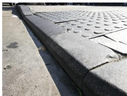
圖 10 緣石坡道坡口與車行道高差過高 圖 11 緣石坡道坡面的磚塊不平整
