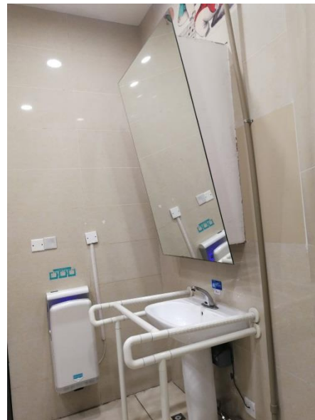
圖 16 洗手盆前留空，但水龍頭高度過高 圖 17 洗手盆上方有安裝傾斜式鏡子
