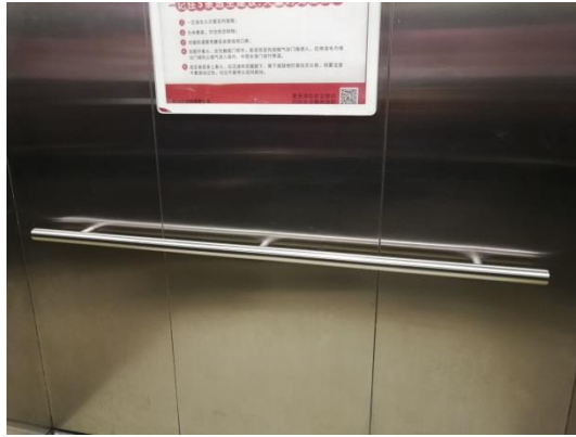
圖 27 電梯機廂內採用圓形單層扶手
