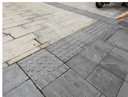
圖 4 盲道轉彎處設置提示
