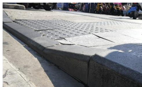
圖 10 緣石坡道坡口與車行道高差過高 圖 11 緣石坡道坡面的磚塊不平整
