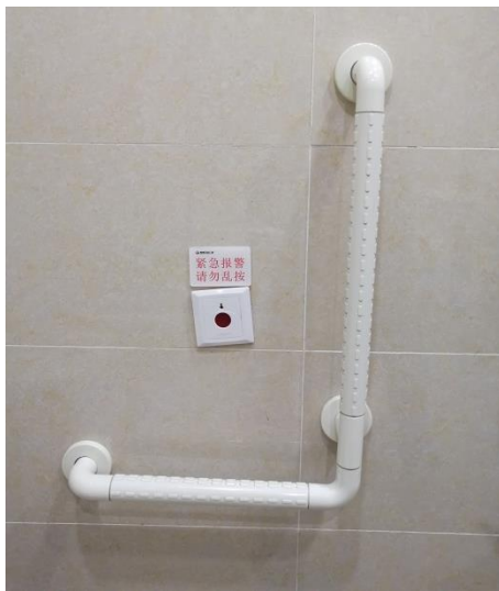
圖 19 呼叫按鈕的高度高於標準高度
