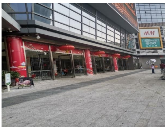
圖 4 無障礙出入口避雨設施
