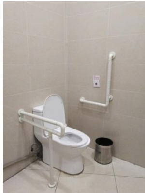
圖 14 無障礙廁所設置安全扶手 圖 15 垂直安全扶手高度過低
