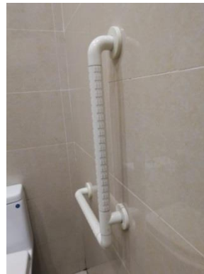
圖 14 無障礙廁所設置安全扶手 圖 15 垂直安全扶手高度過低
