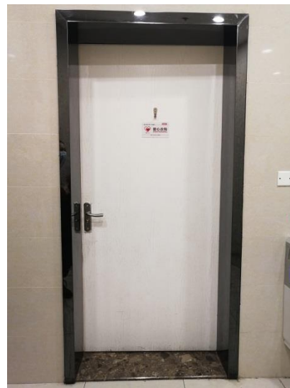
圖 20 掛衣鉤高度高於標準高度
