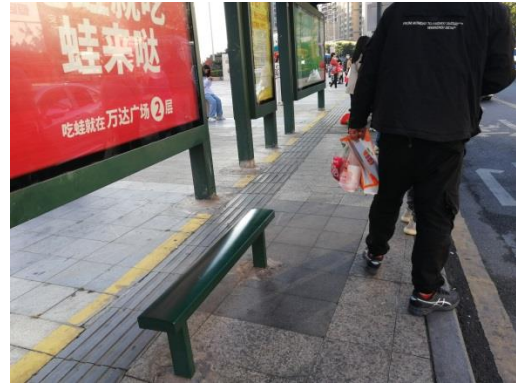
圖 33 公車月臺盲道與人行道中的相連 圖 34 盲道設置在站牌的前方，間隔較小
