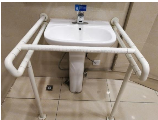
圖 16 洗手盆前留空，但水龍頭高度過高 圖 17 洗手盆上方有安裝傾斜式鏡子
