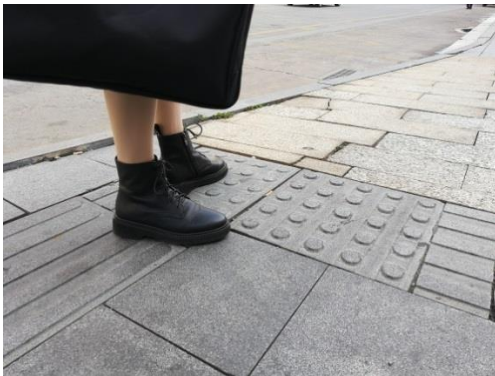
圖 3 盲道轉彎處設置提示盲道
