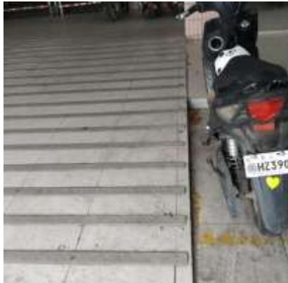
圖 5 入口處設置了緣石坡道，並有緩衝帶。
