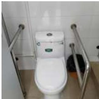
圖 28 門不能改完全被打開，被右側的扶手擋住，並且缺少設置緊急按鈕
