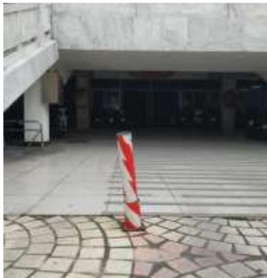
圖 4 柱子傾斜，影響輪椅通過。
