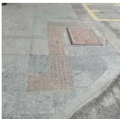
圖 15 距離入口處一小段距離缺少盲道設置
