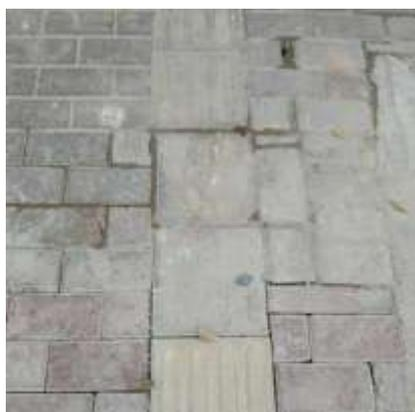
圖 12 盲道凹凸不平，盲道破損
