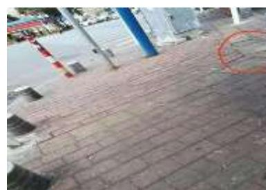
圖 10 盲道磨損嚴重且有裂痕
